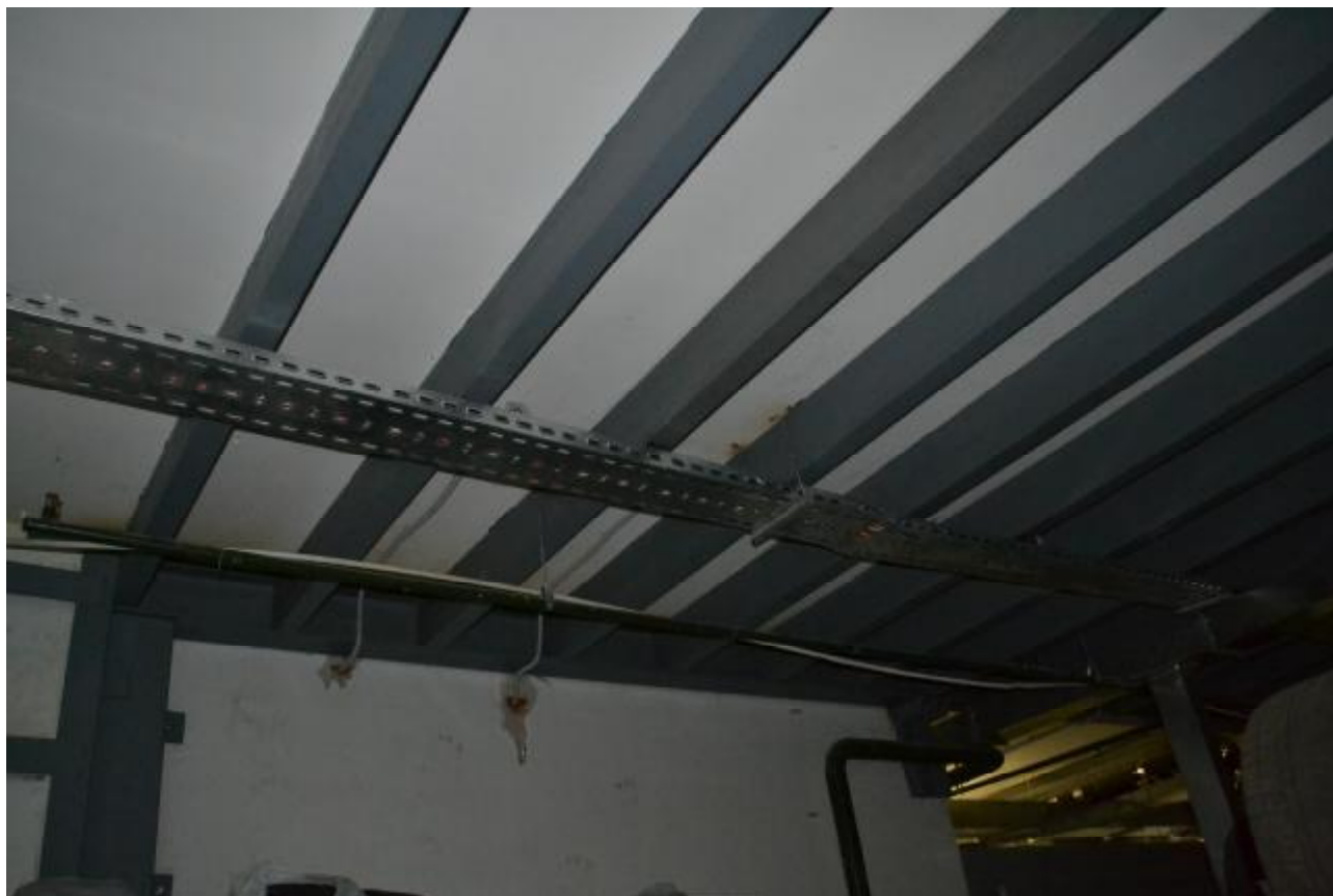
Фото 1. Общий вид рамы усиления.
